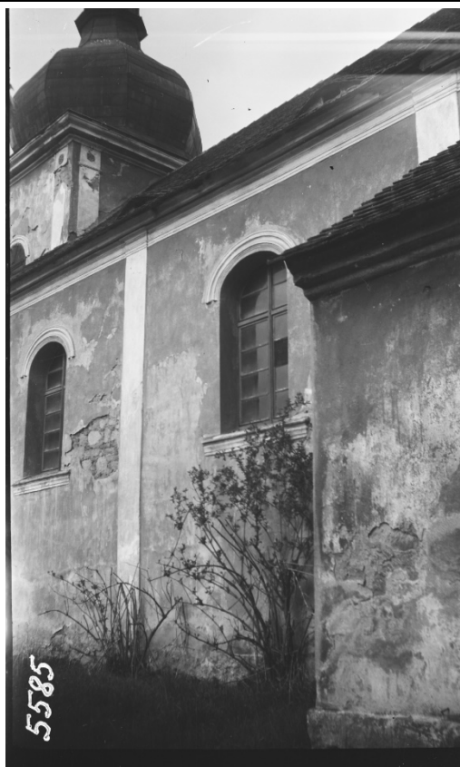
Jižní průčelí lodi v pohledu od jihovýchodu. Foto: 1962, sbírka negativů NPÚ ÚOP v Ústí n. L., sig. 5585.
