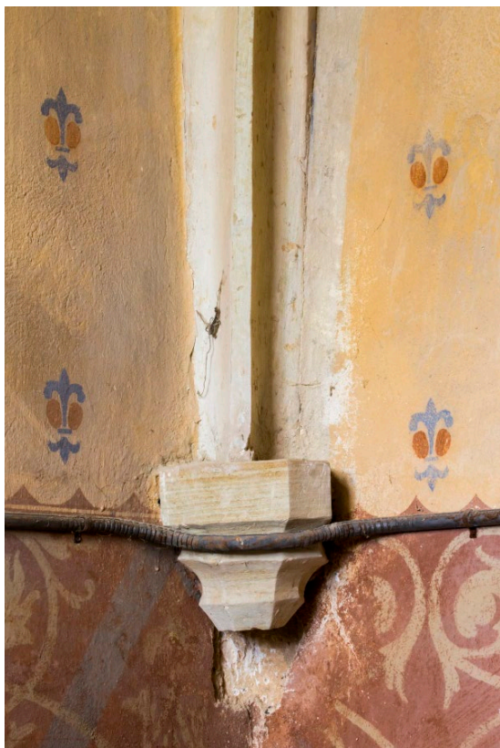
Detail severozápadní konzole presbytáře. Foto: Marta Pavlíková 2019.
