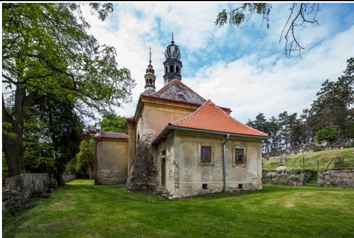
Celkový pohled od jihovýchodu. Foto: Marta Pavlíková 2019.
