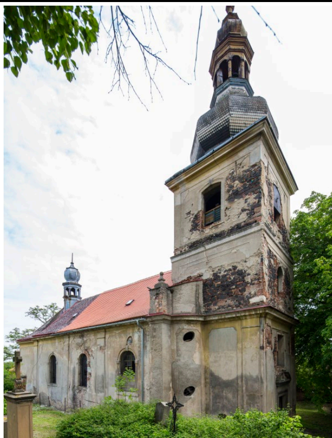
Celkový pohled od severozápadu. Foto: Marta Pavlíková 2019.
