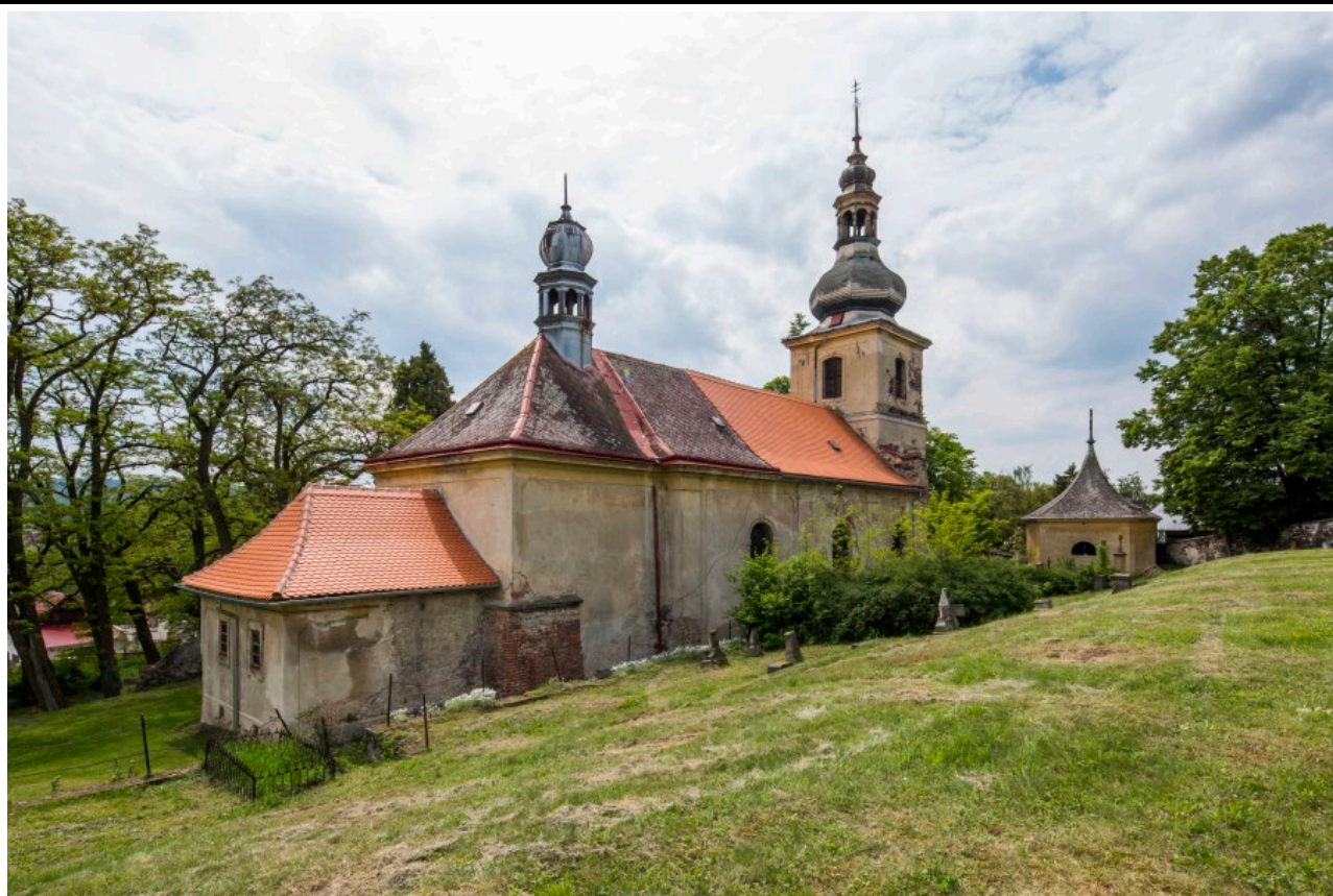
Celkový pohled od severovýchodu. Foto: Marta Pavlíková 2019.
