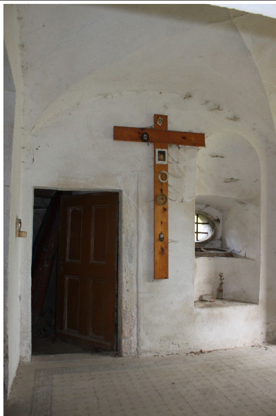
Jižní stěna podvěží v pohledu od severu. Foto: Lucie Radová 2012.
