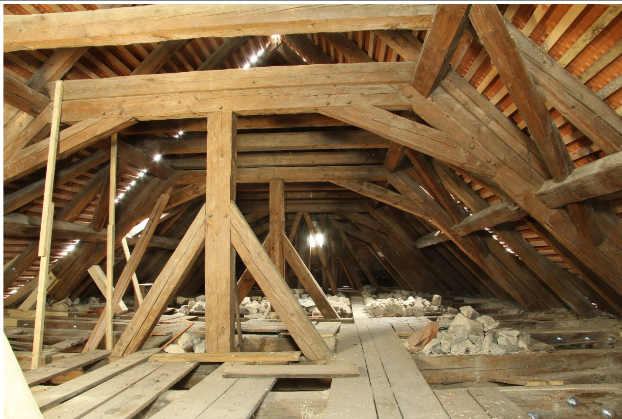
Pohled do krovu nad lodí od západu s průhledem do krovu nad presbytářem. Foto: Jaroslav Skopec 2019.
